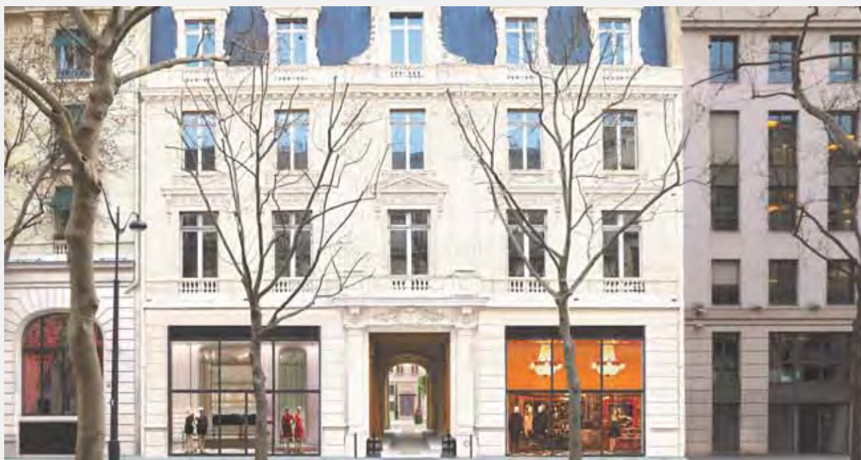
在巴黎的21 avenue Kléber的翻新工程已經竣工，呈現煥然一新的面貌，並與主要的辦公室及零售租戶簽訂了租約。
