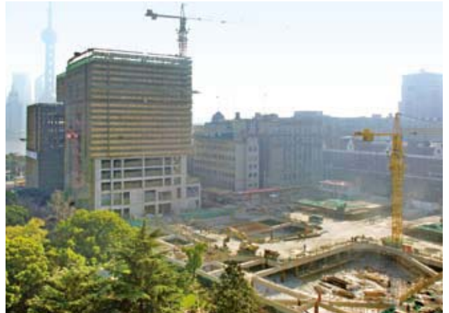
年內，酒店及公寓式酒店大樓的建築工程進度顯著
