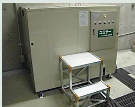
東京半島酒店於2009年引進「Gomizer」，此台機器透過具成本效益且環保的酵母／細菌程序將容易腐爛的廢物轉化為可安全排放至污水系統的液體，每日可處置逾50公斤廢物。截至3月1日，估計已處理15,000公斤已腐爛廢物。
