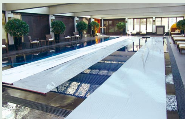
覆蓋王府半島酒店的游泳池面，以降低水及熱能流失，從而達到節水及節能目標。
